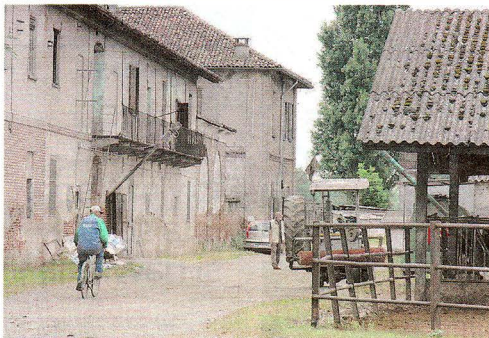
FRAZIONE Il borgo di Castello attende di essere rimesso a nuovo
